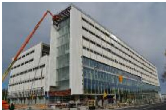
Nova Clínica Girona ubicada a la Carretera de Barcelona nº206, a Girona
