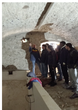
Visita a l'obra en rehabilitació a Girona, de Construccions SALICHS SA de Lloret
